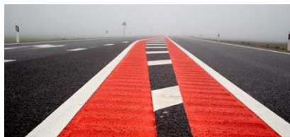
1 pav. Ženklinimas karštu plastik
