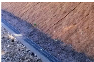
https://www.apstatyba.lt/naturalaus-pluosto-prieseroziniu-paklotu-analize-1545 pav. Sankasos šlaito tvirtinimas šiaudų dembliais
