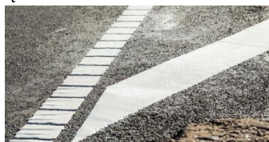
2 pav. Ženklinimas šaltu plastik
