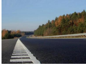
3 pav. Struktūrinis kelio ženklinimas
