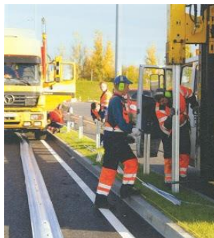
http://www.biseris.lt/projektai/gatves/ pav. Statramsčių kalimas į žemę
